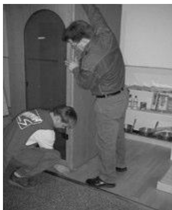
Attention de ne pas cogner la porte ou de la laisser tomber pendant le montage de celle-ci.
