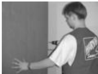
Les coins sont assemblés de l'extérieur avec 4 vis 50mm.
